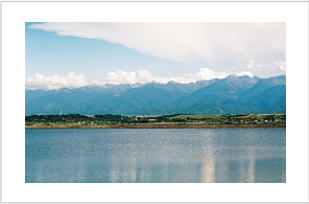
Olt-Stausee mit den Südkarpaten im Hintergrund (nahe der Stadt Avrig )
