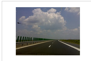
Autobahn in Rumänien
